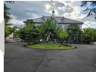
②記念館(改修工事中) を左に抜ける
